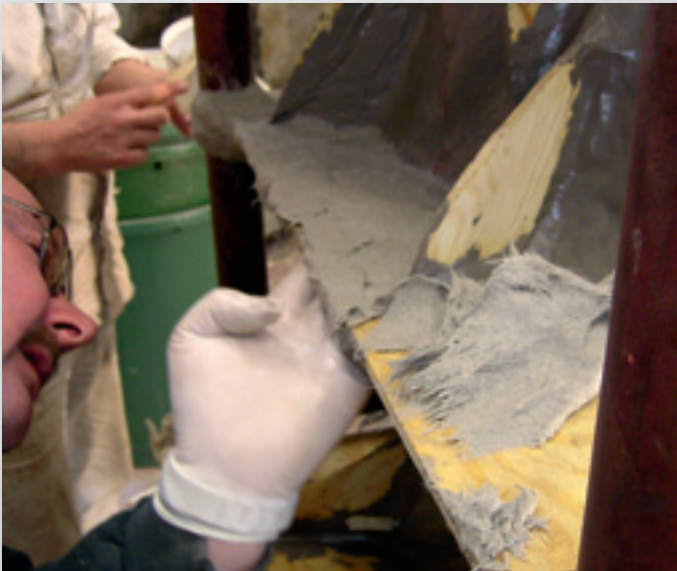
19 | Application de rigidité avec Epoxy EP-F de type VB
