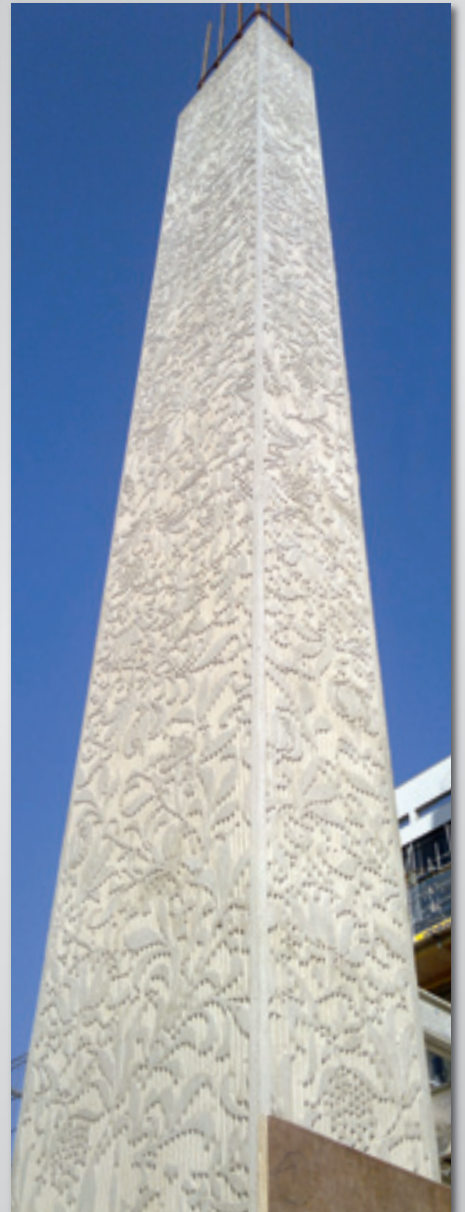
Ornement – technique de fraisage CNC – moules élastomères PUR – éléments en béton blanc
