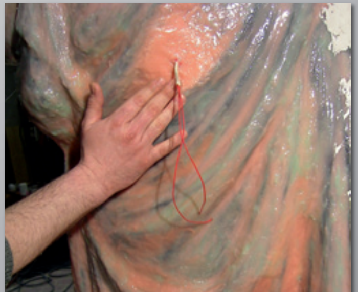
11 | Incorporation des boucles de retenue pour la fixation dans la chape support
